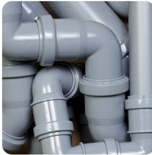
2. Voirie, réseaux divers
