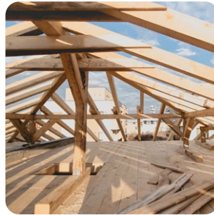
3. Structure, maçonnerie, gros œuvre, charpente
