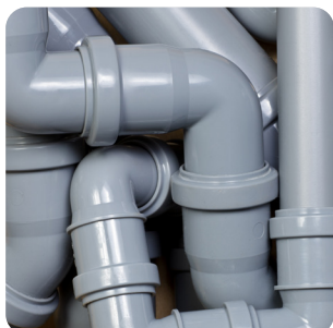
2. Voirie, réseaux divers
