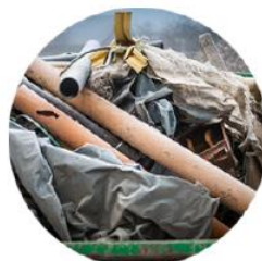
Déchets issus des Travaux Publics
